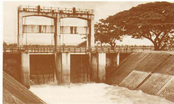
ประตูระบายน้ำ
